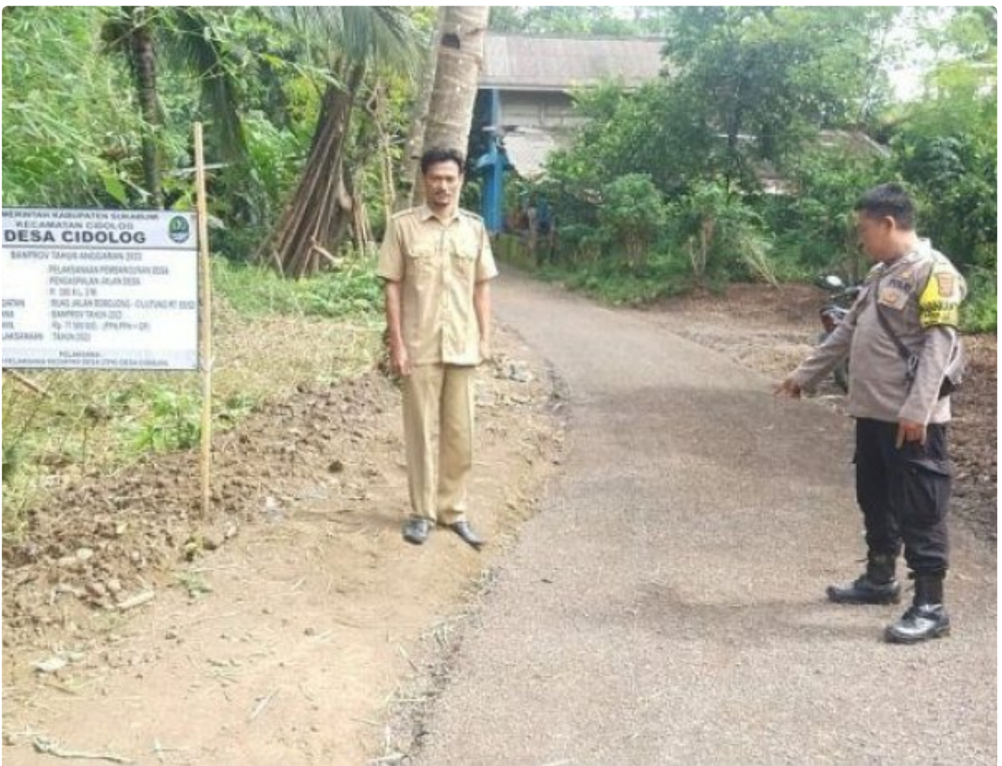
Bhabinkamtibmas Desa Cidolog Awasi Pembangunan Desa
