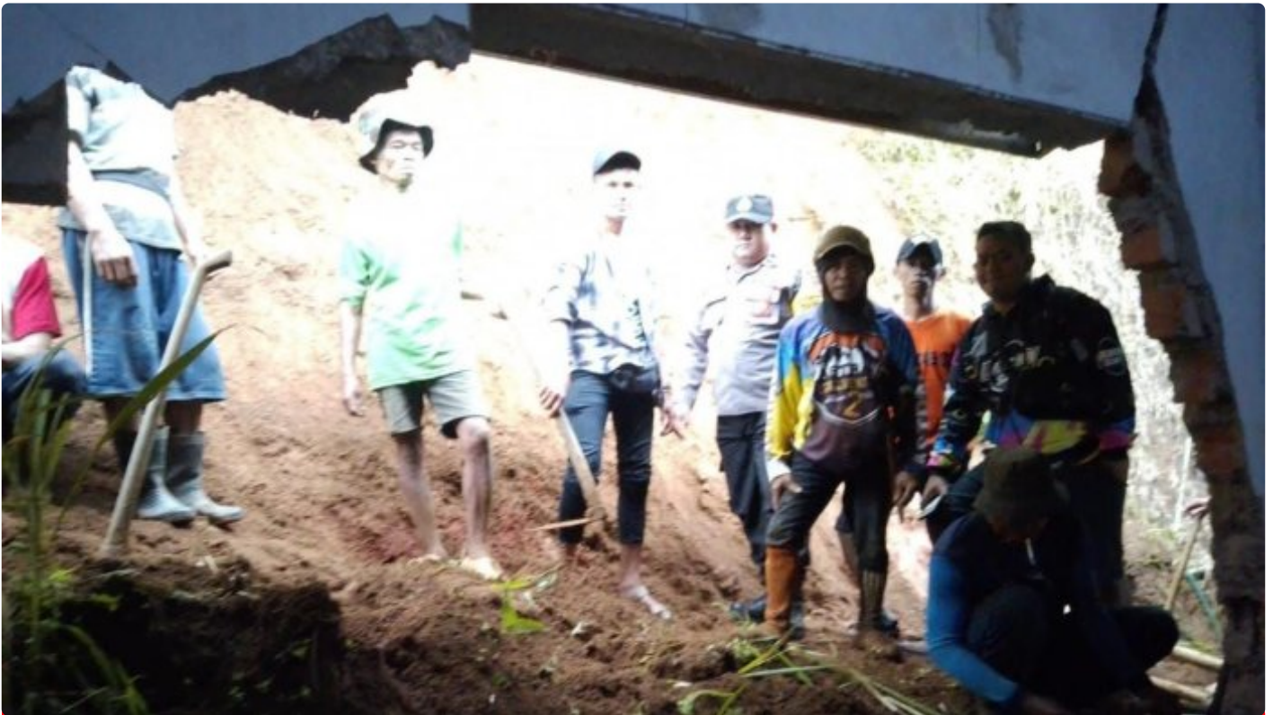
Kesigapan Bhabinkamtibmas Bantu Bersihkan Rumah Warga Akibat Tanah Longsor
